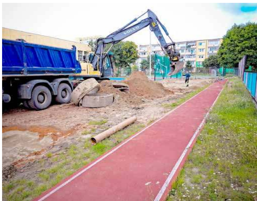
Bieżnia przy SP nr 11 w budowie. Fot. Krzysztof Kempski
