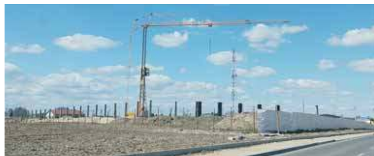
Na placu budowy pracuje wysoki dźwig. Od ul. Leszno budowę oddziela metalowe ogrodzenie
