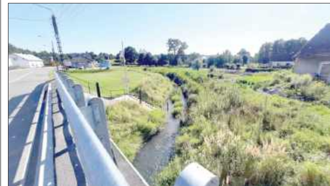
■ Sprawdziliśmy, jak Sumina wygląda na wysokości mostu w ciągu drogi wojewódzkiej nr 922. Wydaje się, że również w tym miejscu rzeka potrzebuje prac konserwacyjnych.
