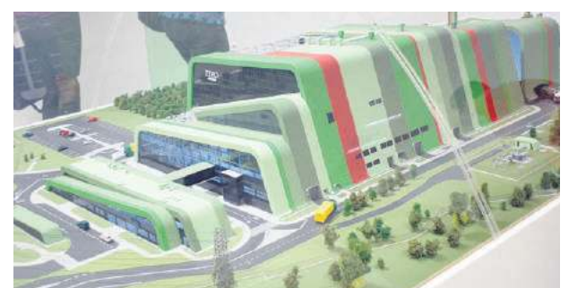
Krakowska spalarnia to jeden z nowoczesniejszych zakładów tego typu w Polsce.
