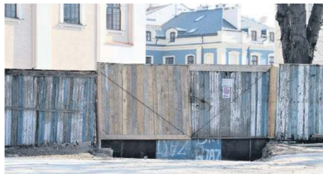
Bramę poprawiono i wzmocniono. Jest szansa, że będzie to dobry początek do kolejnego etapu budowy zamojskiego Domu III Tysiąclecia.
