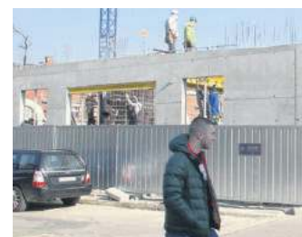
Apartamentowiec powstaje na zwrótnym tempie.
