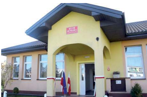
Koszt ogólny inwestycji to ponad 2,3 mln zł, z czego 1,9 mln zł to dofinansowanie unijne
