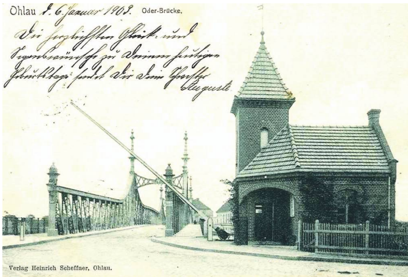
Budynek którego nie ma
