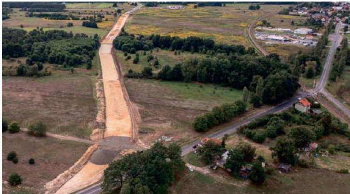
Nowa droga zapewni przedsiębiorcom łatwiejszy dojazd do swoich firm oraz ułatwi życie mieszkańcom Starego Żabna (fot. materiały UM w Nowej Soli)
