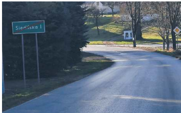
Przebudowa drogi powiatowej Suchodoły-Siedliska- Ksawerówka
