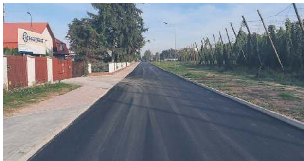
Przebudowa ul. Granicznej w Krasnymstawie
