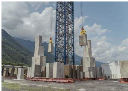
6. Budowa betonowego magazynu energii w Szwajcarii
