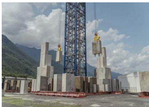
6. Budowa betonowego magazynu energii w Szwajcarii
