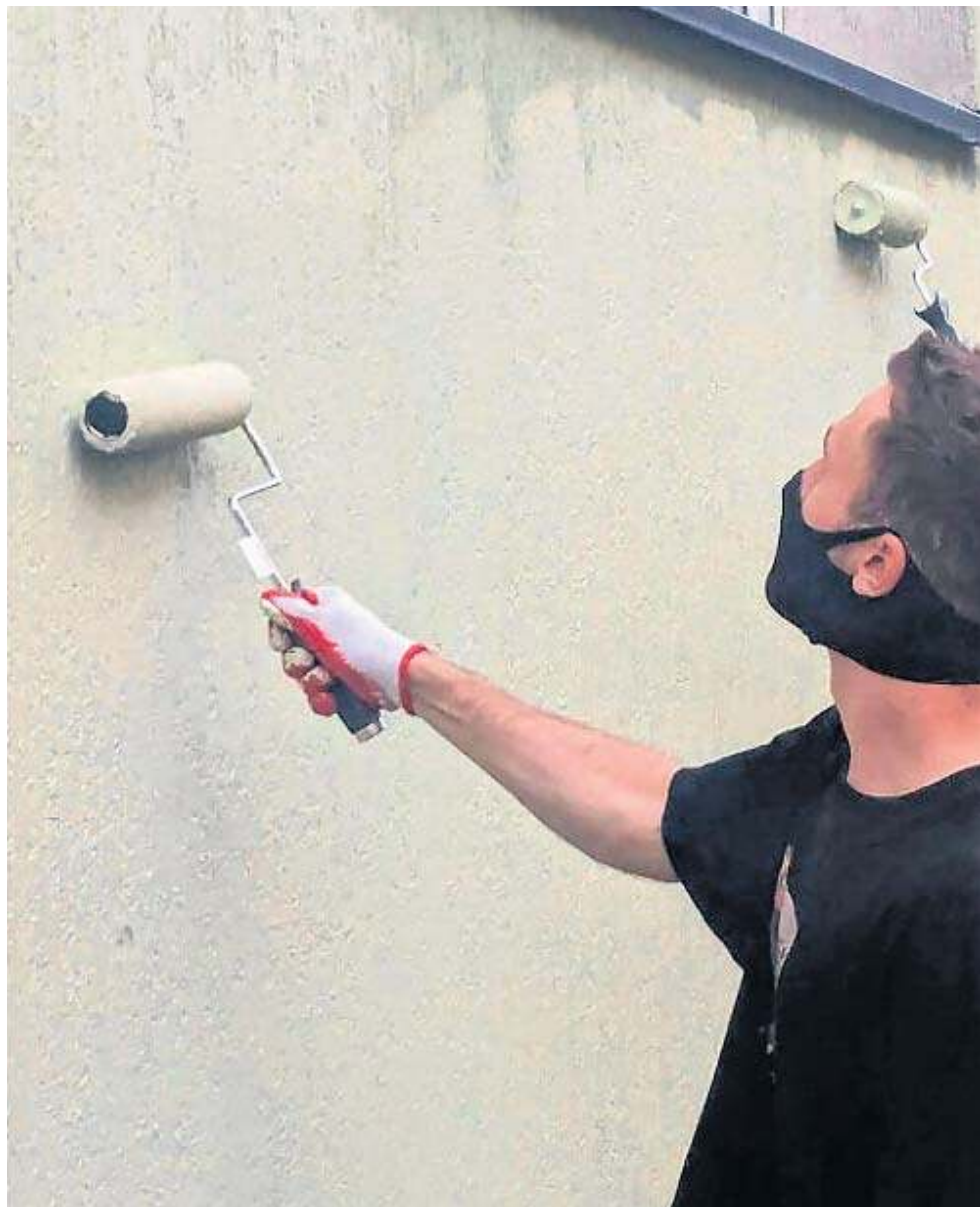
FOT. ARCHIUM PEYOWITNE GUM-Y
