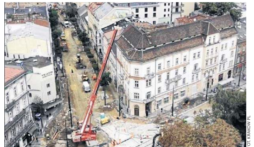
Przy Teatrze Bagatela trwa teraz montaż kluczowych elementów betonowych remontowanego skrzyżowania
