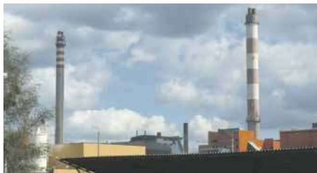
Inspektorzy ustalili, że informacja o rozszczelnieniu instalacji jest prawdziwa. 9 sierpnia na wydziale produkującym kwas siarkowy, uszkodzony został rurociąg
