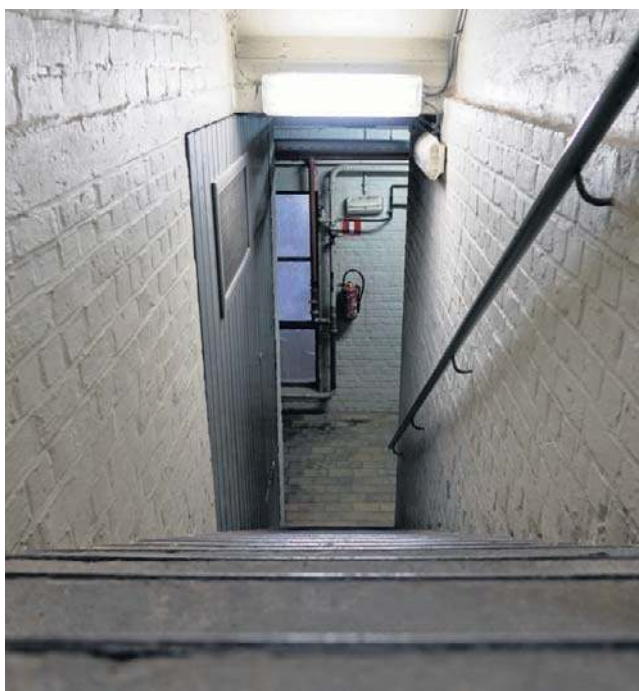
Schron schronowi nierówny. Firmy z branży podpowiadają, na co zwracać uwagę przy takich inwestycjach
