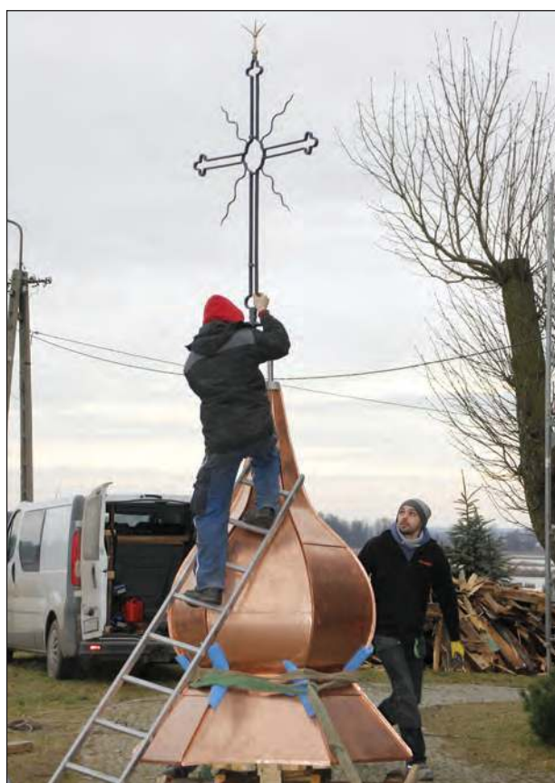
Remont podzielono póki co na dwa etapy. Pierwszy polega na wymianie części dachu oraz zainstalowaniu nowej wieżyczki wykonanej z blachy miedzianej. Jej zwieńczeniem jest krzyż, który znajdował się dotychczas na kościele. - Wyprostowaliśmy go, odnowiliśmy i będzie dalej nawiązywał historycznie do tego co było - mówi ks. Wiesław Nestoruk
