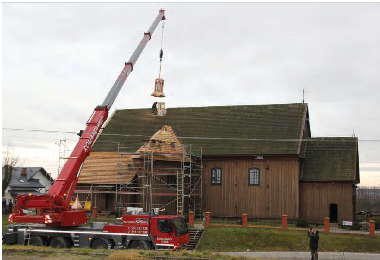
W piątek przy kościele stanął 60-tonowy dźwig, którego ramię ma ponad 40 metrów. Tylko takim sprzętem można było przeprowadzić montaż wieżyczki
