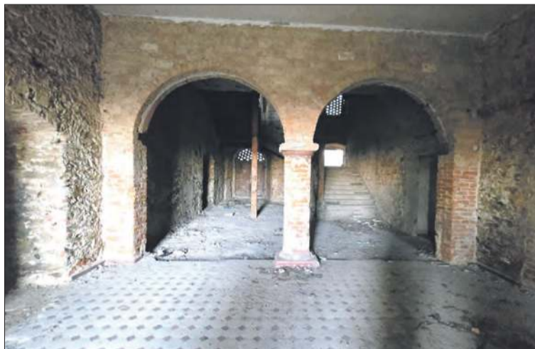
Główny hol pałacu z zamurowanym wyjściem do parku
