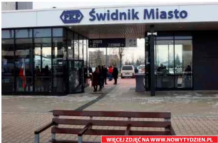
Dworzec PKP w Świdniku w końcu otwarty
