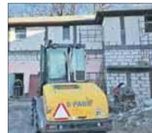
Prace przy remizie potrwać do czerwca 2022 roku
