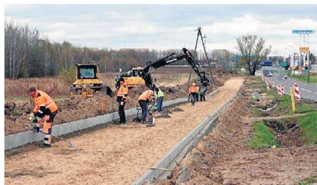
Wzdłuż ulicy Energetyków trwa budowa nowego ciągu dla pieszych i rowerzystów. Są już układane krawężniki.
