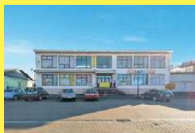
Dom handlowy w samym centrum Janowa Podlaskiego, 885 851 161
