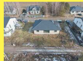
Dom z pompą ciepła i fotowoltaiką - Porosiuki, 604 494 489
