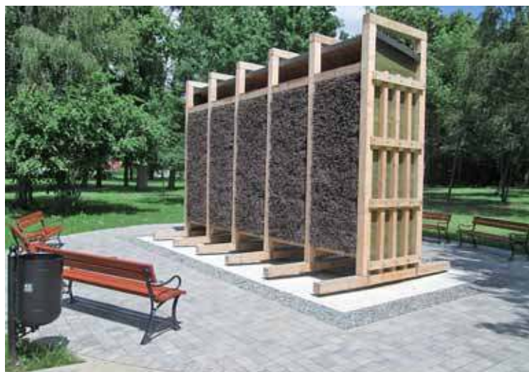
Tężnia przy ul. Dworcowej
