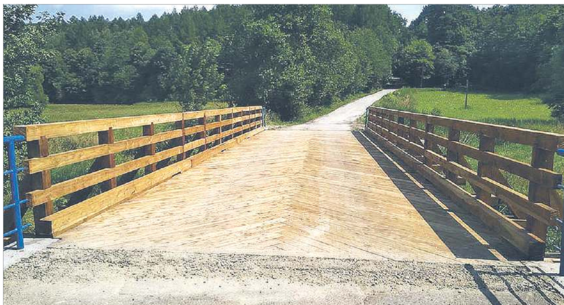
Most na rzece Żółkiewce, w ciągu drogi do Widniówki
