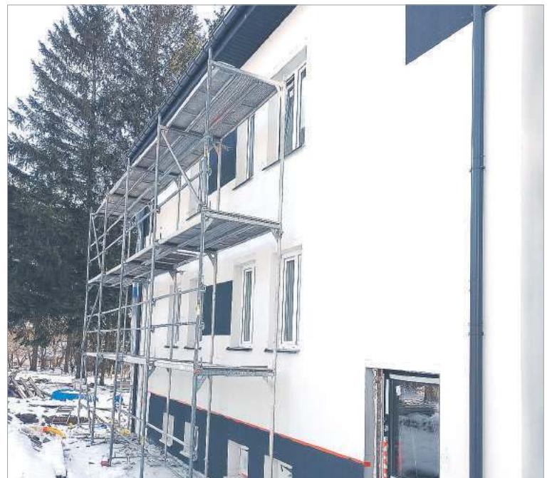
Adaptacja budynku na potrzeby świetlicy w Orchowcu
