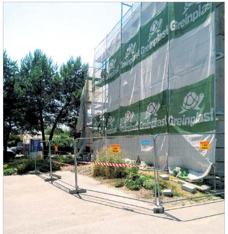
Termomodernizacja budynku Urzędu Gminy w Gorzkowie
