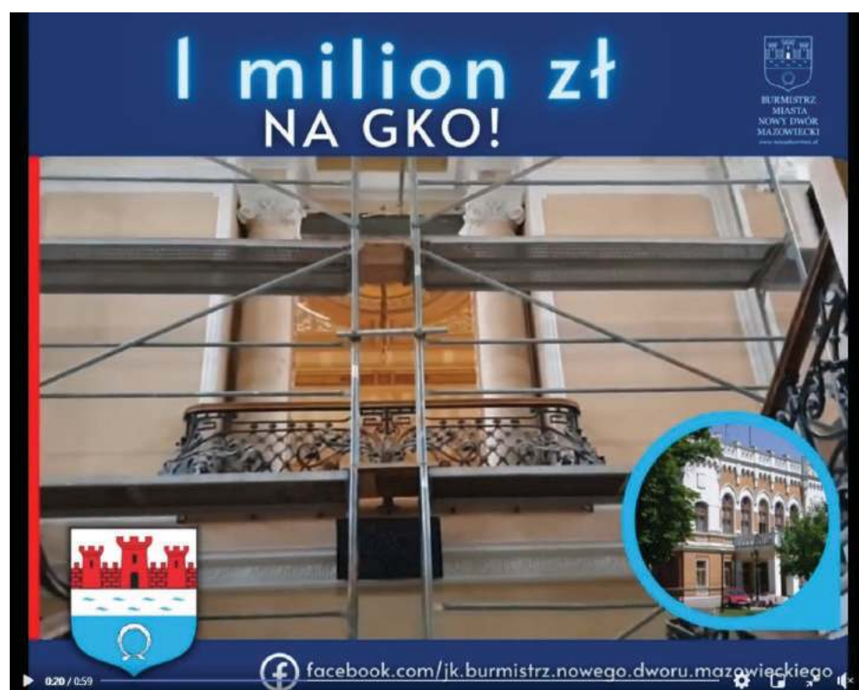
Pracownicy są w trakcie czyszczenia sztukaterii wewnątrz budynku
