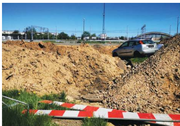
Na terenie placu budowy znajdują się porzucone przez właściciela auto, którego nikt do tej pory nie odebrał
