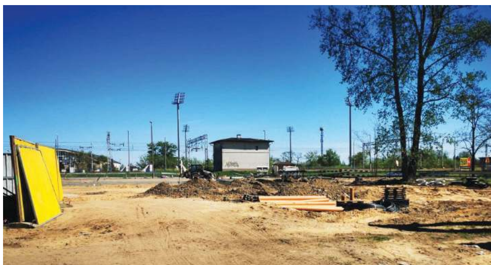
To, że prace budowlane nie posuwają się w ekspresowym tempie widać gołym okiem
