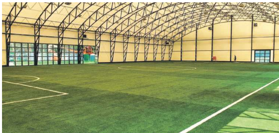
W hali ułożono już sztuczną nawierzchnię boiska
