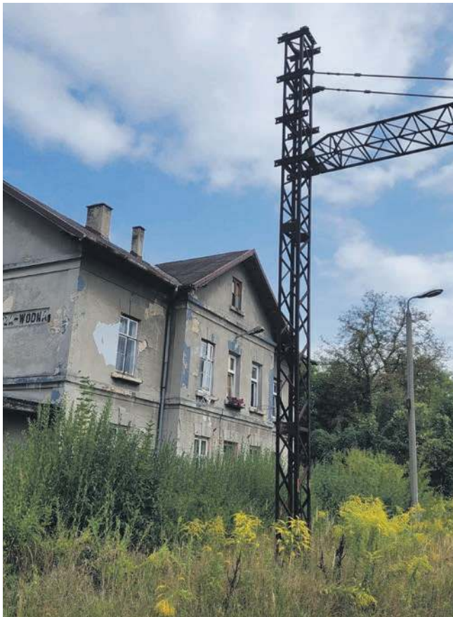
Budynek stacji Siersza Wodna od strony torów coraz mniej widoczny. Na piętrze wciąż są mieszkania.
