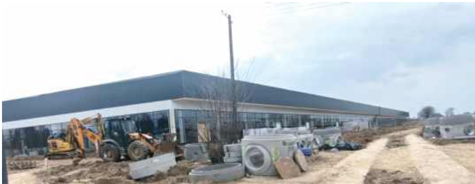
Targowa Park - plac budowy, kwiecień
