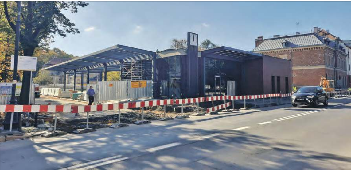
Budowa dworca autobusowego – centrum przesiadkowego w Prudniku to jedna z ważniejszych inwestycji gminy w 2021 i 2022 roku
