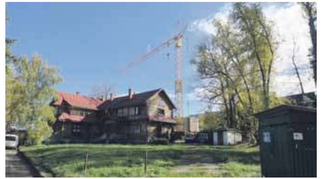
Na działce Za Strugiem 5a stoi górujący nad okolicą żuraw budowlany, ruszyła budowa nowego hotelu.
