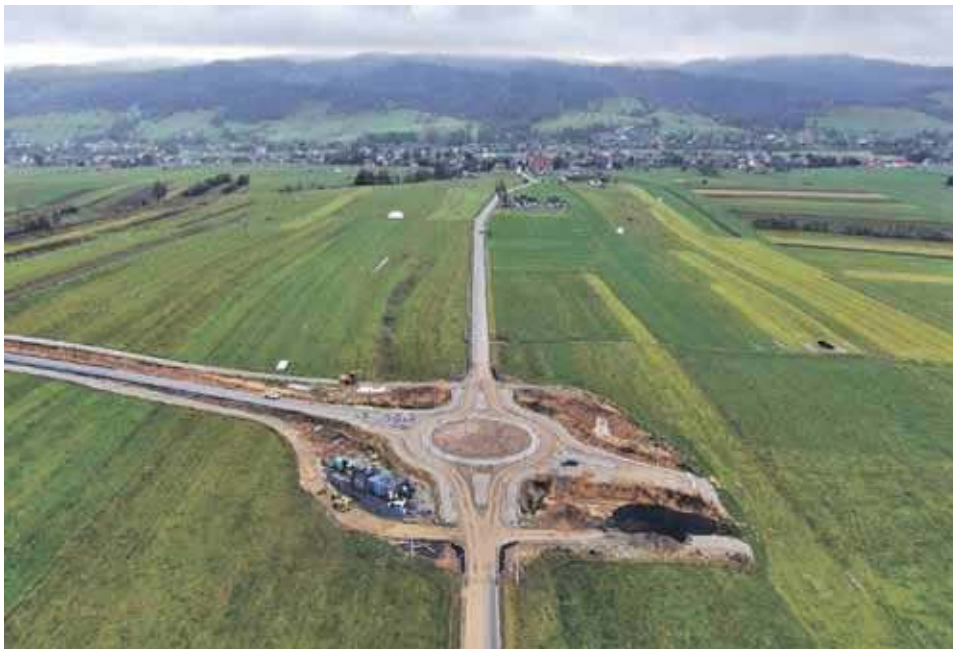
Po nowym rondzie pomiędzy Gronkowem a Ostrowskiem można już jeździć, choć nie ma jeszcze wylanego asfaltu.
