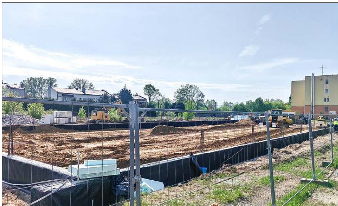
(nan) Na placu budowy uwijają się ekipy budowlane. Jest szansa, że obiekt będzie gotowy już w lipcu.
