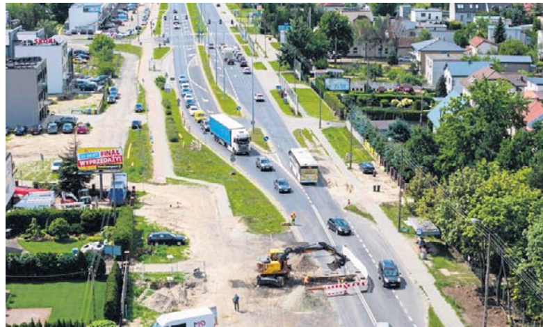
Ulica Olsztyńska na przebudowywanym fragmencie
