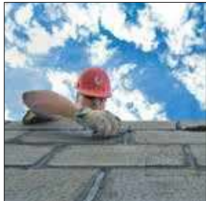
Do wnoszenia murów, kiedy na dworze panuje temperatura poniżej 0 stopni Celsjusza, należy zastosować zimową zaprawę
