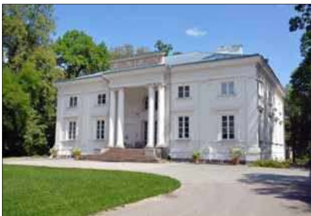
Pałac w Cieleśnicy przetrwał mimo, iż w 1920 r. trawił go pożar, a po 1989 r. stał przez wiele lat opustoszały. Dziś przywrócono mu świetność
