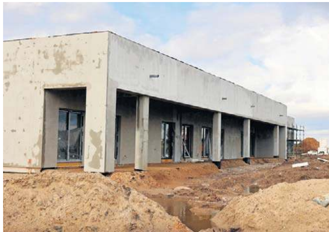
Budynek jest już zamknięty, trwają prace wykończeniowe wewnątrz obiektu
