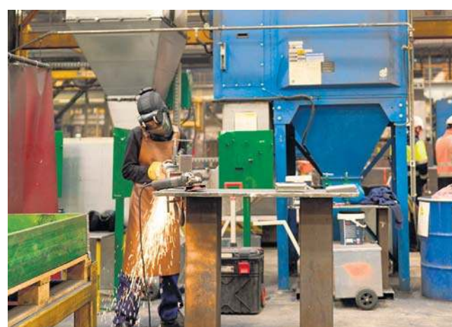
Stalowe elementy fundamentów dla morskiej farmy wiatrowej Baltica 2 powstają w zakładach produkcyjnych w Polsce.
