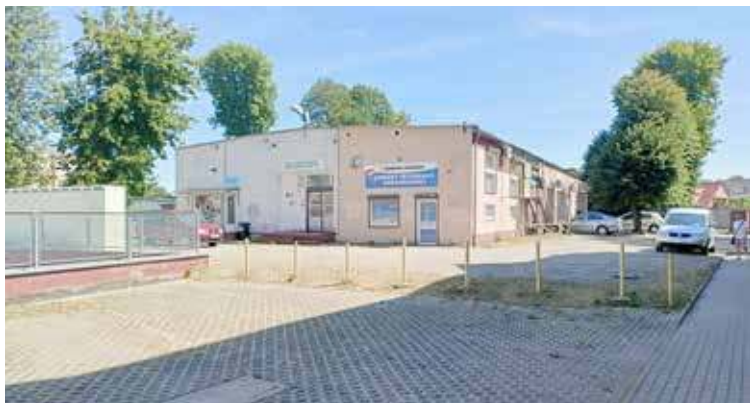
To tu inwestor planował postawić wysoki 8 piętrowy budynek mieszkalny
