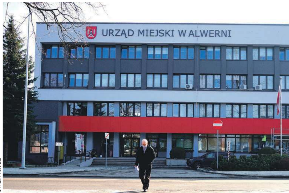
Odnowiony budynek Urzędu Miejskiego w Alwerni
