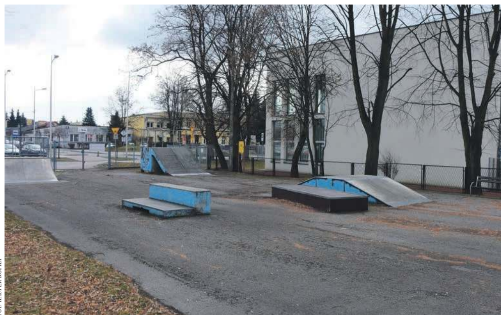
Zniszczone urządzenia w skateparku w Krzeszowicach
