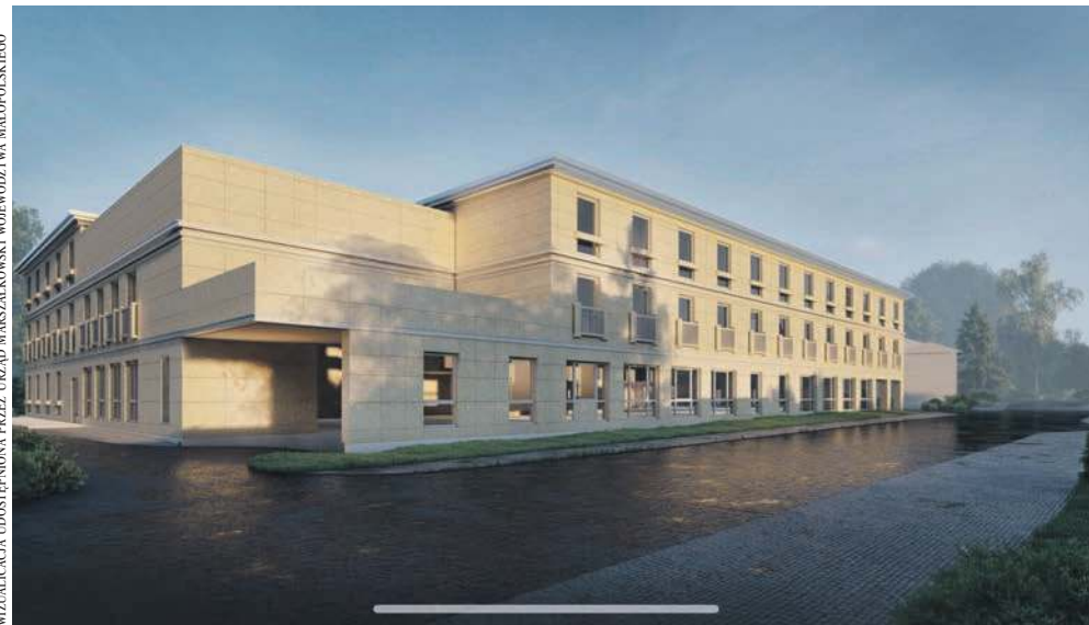
Nowy budynek balneologii zaplanowany po wyburzeniu starych obiektów ośrodka
