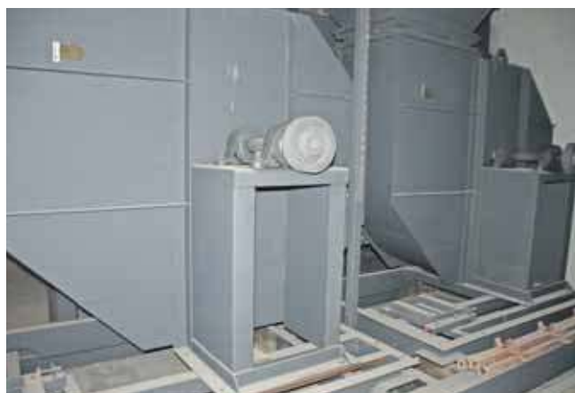
W tym miejscu ma stanąć symulator jazdy na motorze
