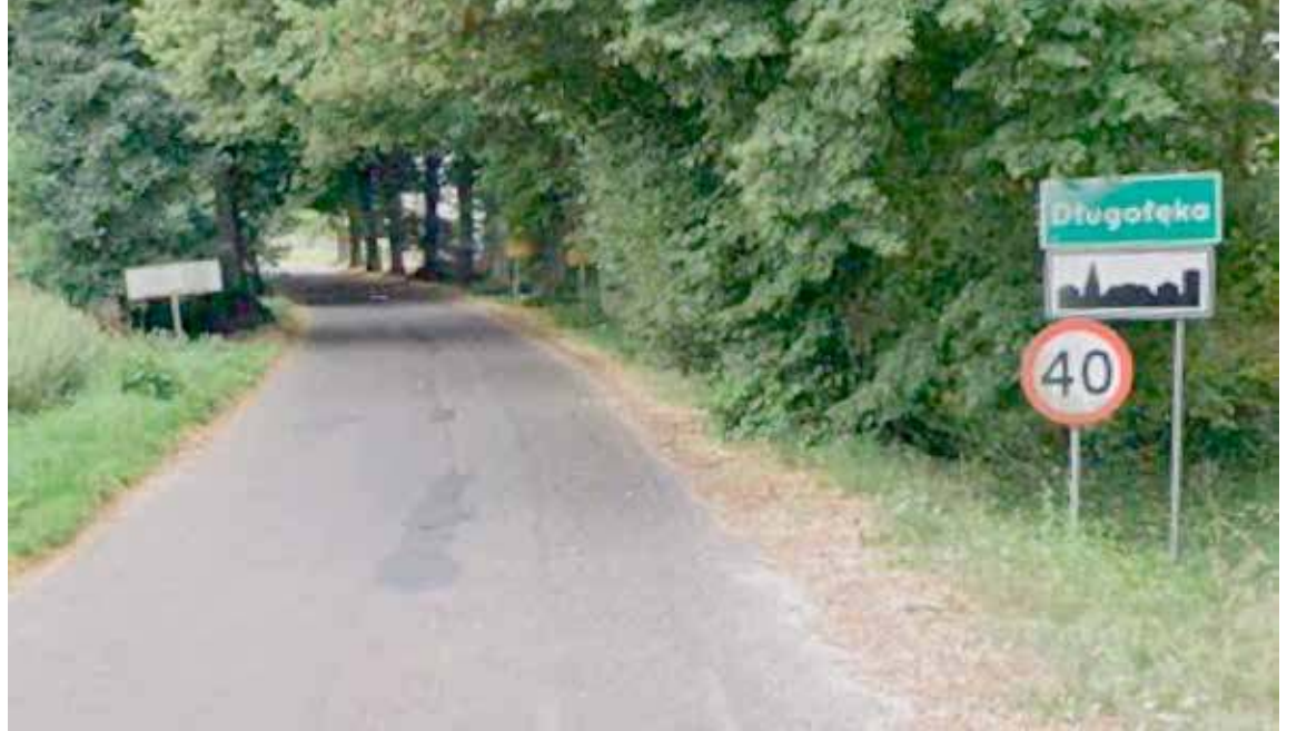
Mieszkańcom przyjdzie jeszcze poczekać na większe prace drogowe
