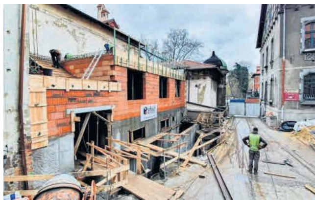
Budowlańcy pracują w teatrze od 2019 roku
