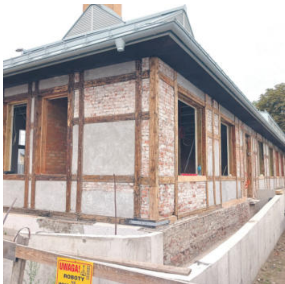
Dworzec w trakcie prac remontowych
