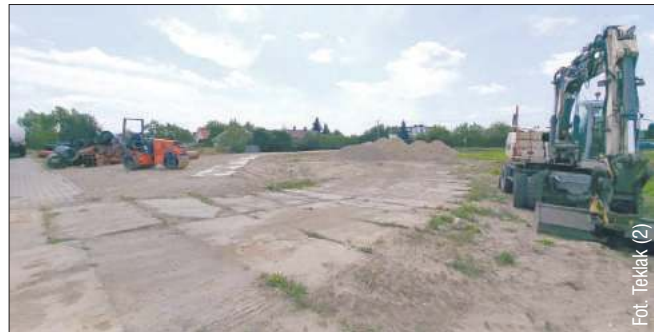
Przy skrzyżowaniu powstał objazd.
