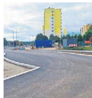
Budowa podzieliła ulicę Owocową na dwie części
