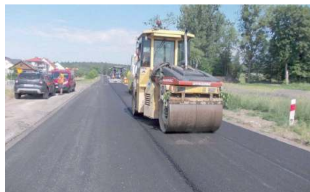
Na początku listopada zakończą się roboty drogowe na odcinkach obejmujących gminy: Biszczu, Potok Górny i Obsza
