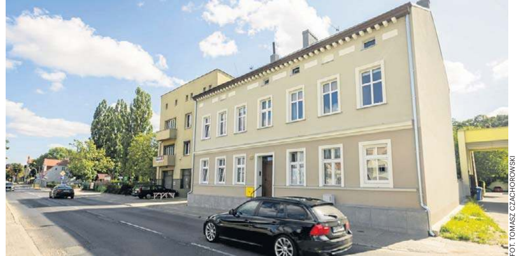
Blisko 130-letnia kamienica przy Toruńskiej 38 zyskała nową elewację. To najdłuższa bydgoska ulica, ma 11 kilometrów długości. Biegnie aż do Łęgnowa Wieś
