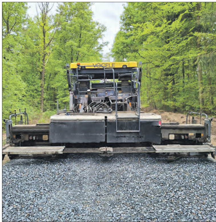
Na kamienny podkład wylany zostanie asfalt
