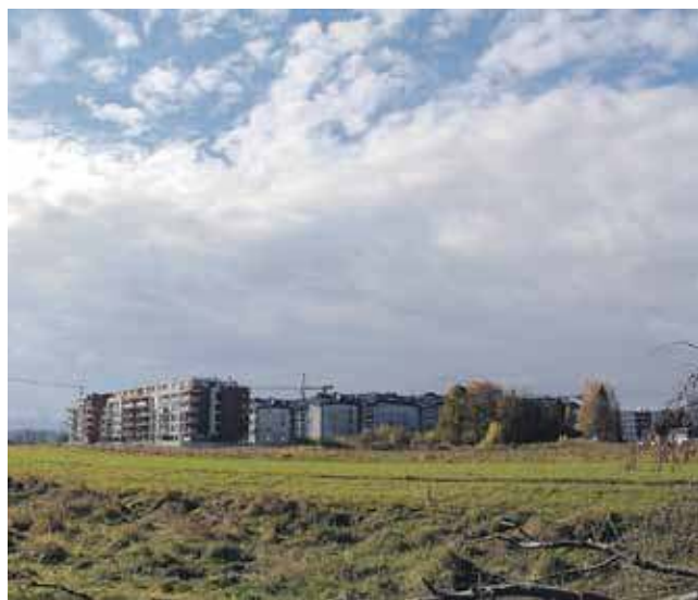
Na Polanie Szaflarskiej stanąć ma blok na kolejne 130 mieszkań.
