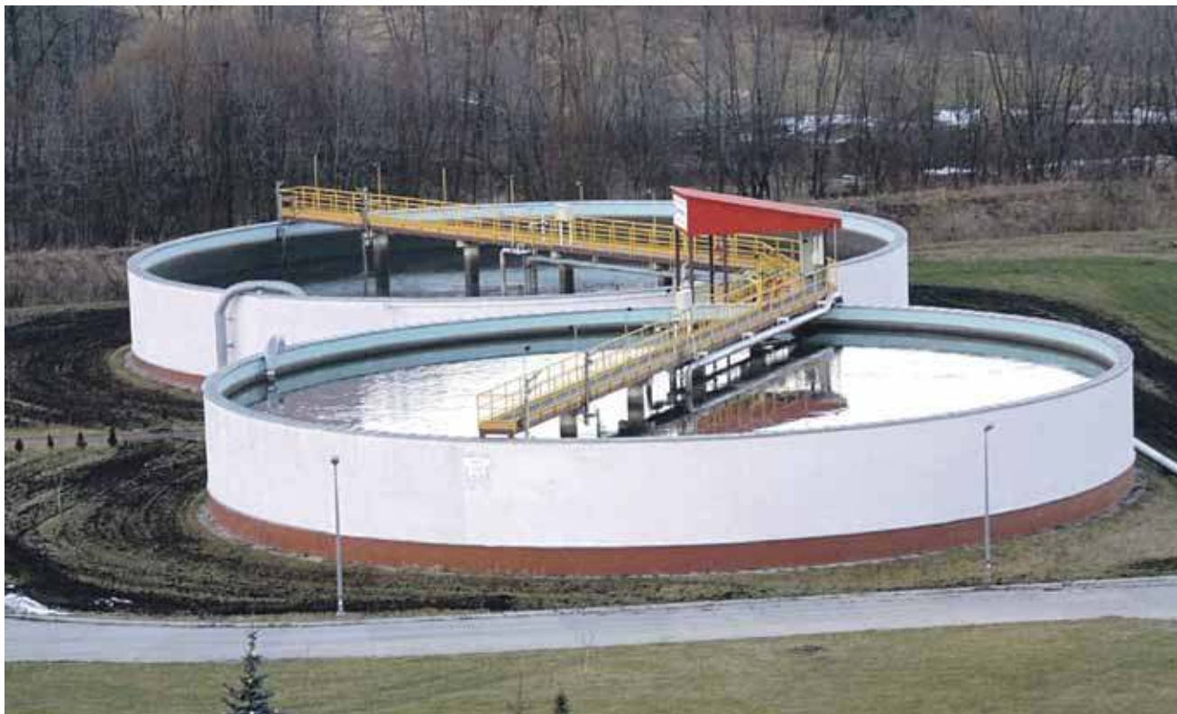
Oczyszczalnia wymaga pilnego remontu.
