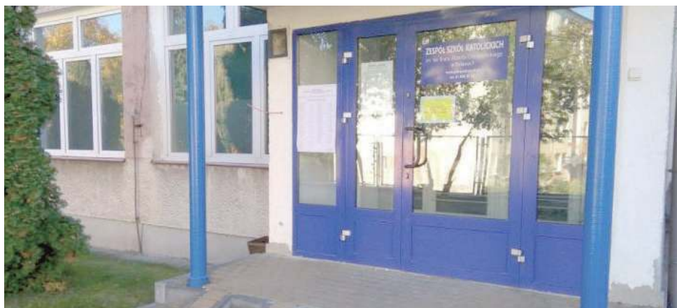
Obecny podjazd przy budynku na ul. Eustachiewicza jest zbyt stromy, przez co niepełnosprawnym trudno jest z niego skorzystać. Na razie jednak urząd nie podjął żadnej decyzji w sprawie jego przebudowy
