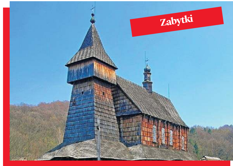
Kościół św. Mikołaja w Bączalu Dolnym został wybudowany najpóźniej w 1667 r. W latach 70. XX wieku został przeniesiony do Muzeum Budownictwa Ludowego w Sanoku. W pożarze spłonął całkowicie.
