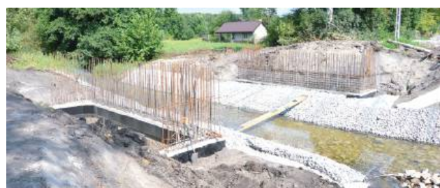
Zakończony został pierwszy etap inwestycji. Wykonane są już prace fundamentowe pod nowy obiekt mostowy w Opolu Lubelskim
