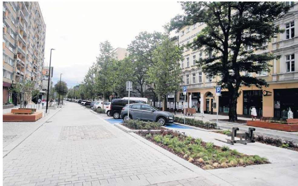
Aleja Wojska Polskiego to nadal plac budowy, a na końcowy efekt prac poczekamy do 15 listopada. Urzędnicy obiecują, że ulica będzie regularnie sprzątana
