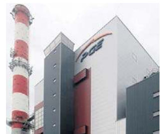
Elektrociepłownia Szczecin była czasowo wyłączona do rezerwy. Obecnie pracuje w normalnym trybie
