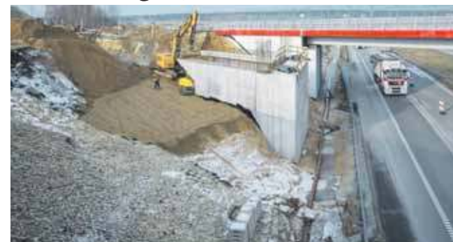
Rozpoczyna się budowa wiaduktu w Pyrzowicach
