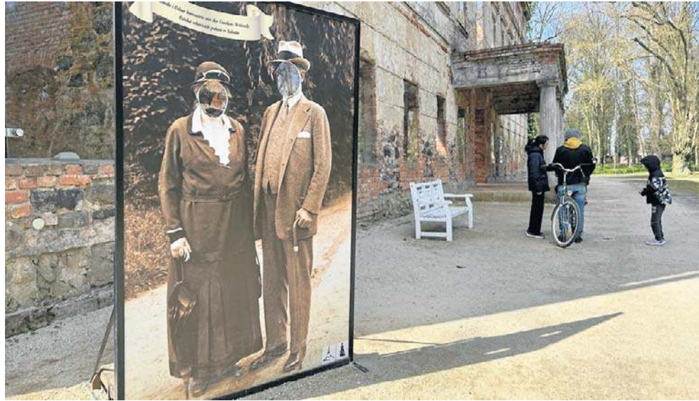
W przeciągu kilkunastu ostatnich lat zapuszczona ruina w zaniedbanym parku zamieniła się w jedną z wizytówek miasta
