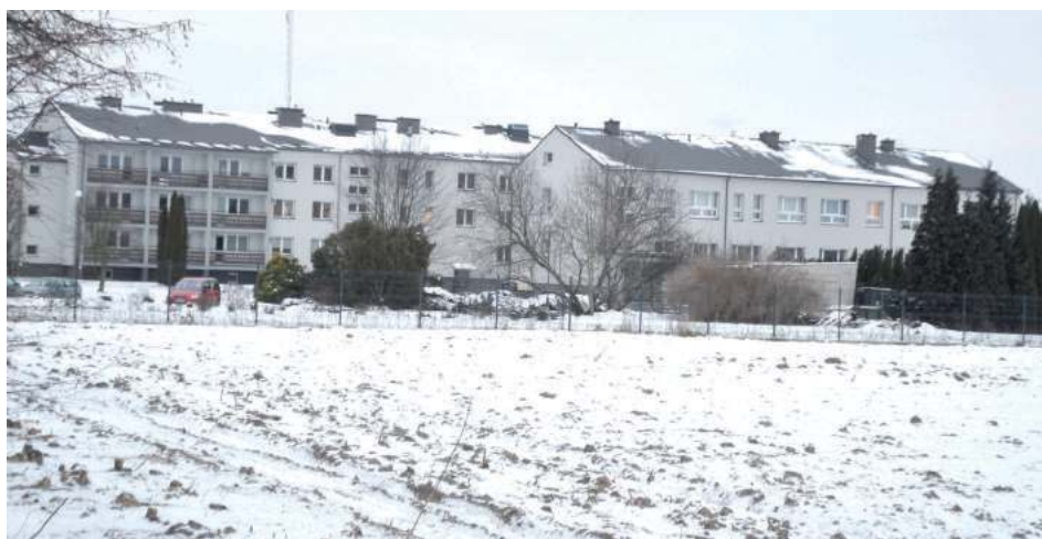
Nowy posterunek policji znajdzie się w sąsiedztwie Domu Pomocy Społecznej. Gmina teraz ustala termin sporządzenia aktu notarialnego. Budowa prawdopodobnie ruszy w tym roku
